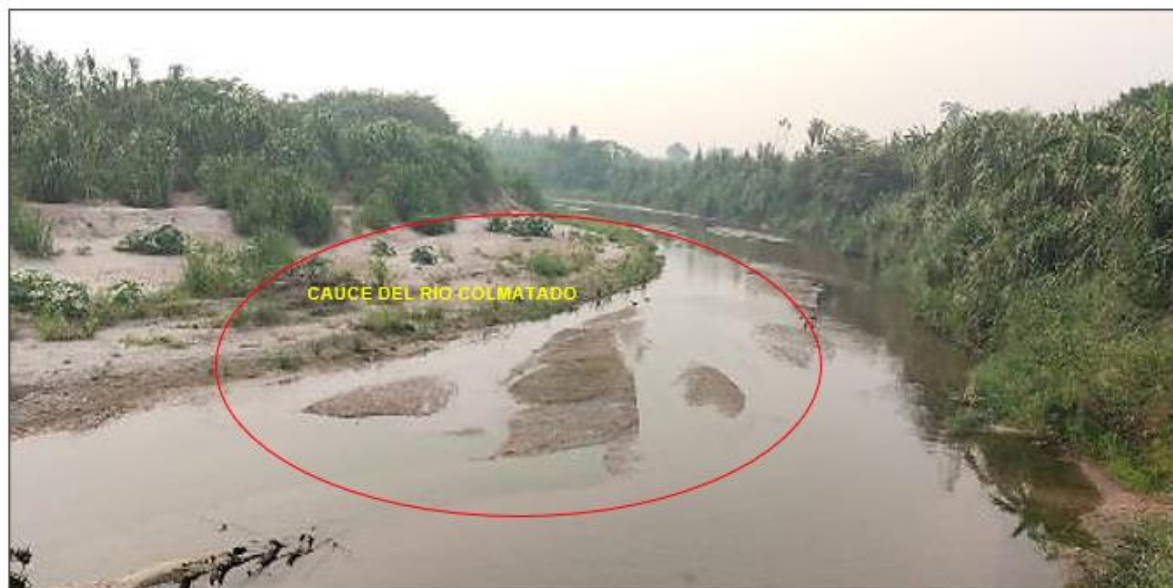
FIGURA N°03: TRAS EL BAJO DE NIVEL DE AGUA EN EPOCAS DE ESTIAJE, SE PUEDE APRECIAR EL TRAMO CRITICO COLMATADO POR SEDIMENTOS DE ARENA, LIMO Y GRAVA, POR LO QUE REQUIERE SU MANTENIMIENTO PARA EVITAR DESBORDE Y POSIBLE INUNDACION DE LA ZONA.
